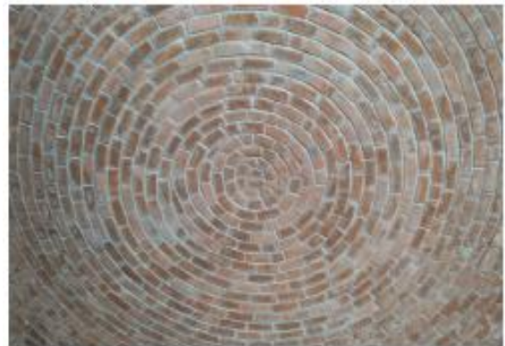
Fig -1: Rohtak Domes (Interior)
